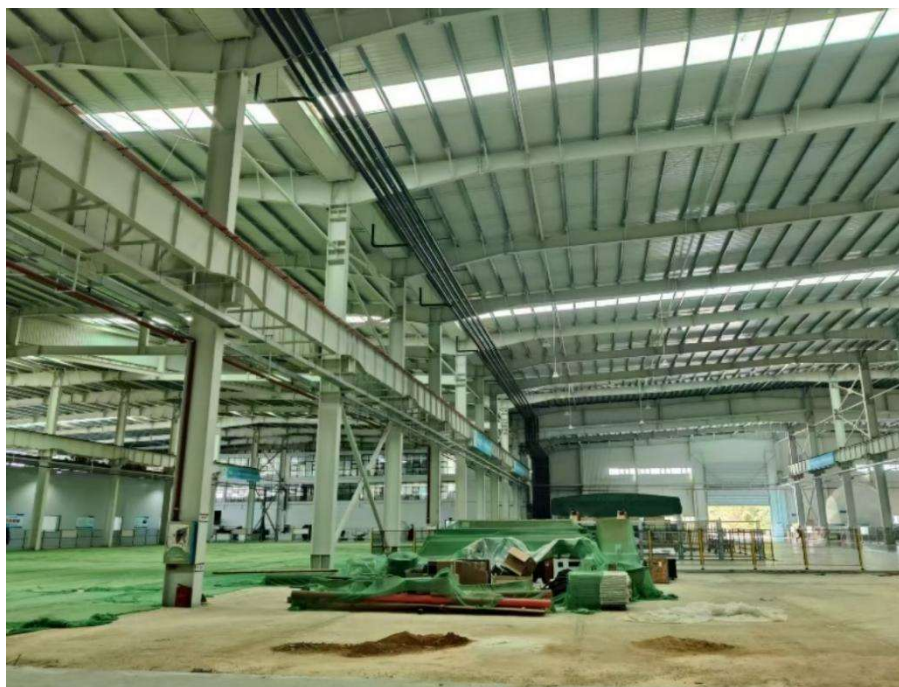
拟建铅房西侧无损检测缓存区
