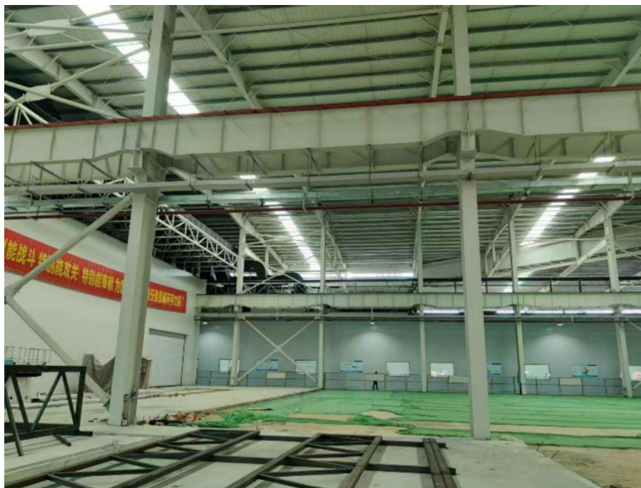
拟建铅房南侧净化区
